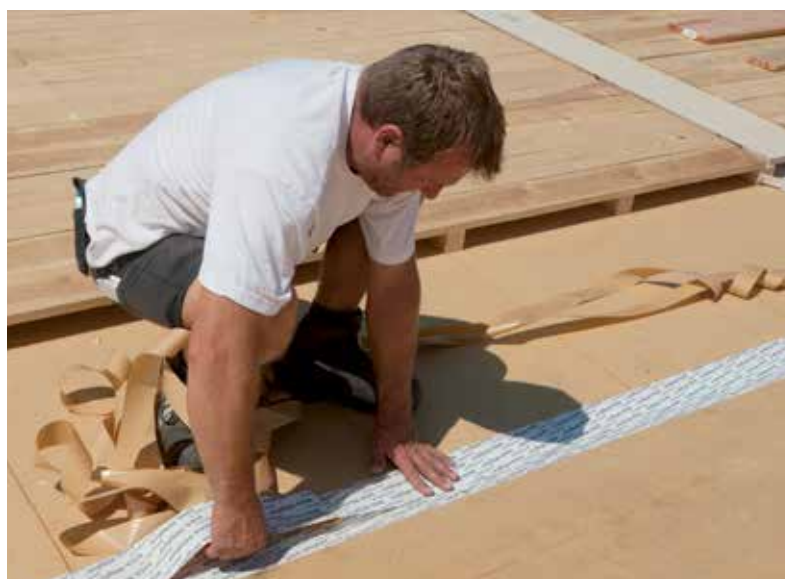
A DHF lemez még kis tetőlejtés esetén is biztonságosan ellátja az alátét szerepét.
